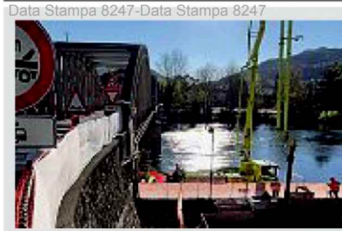
I preparativi per il cantiere del ponte di Brivio
