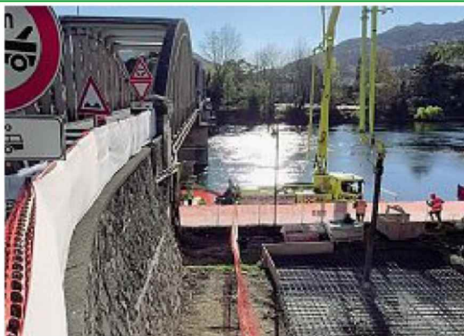
Preparativi La realizzazione della platea d'appoggio della gru
