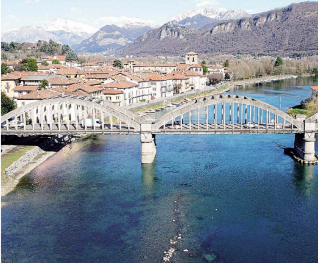
Il ponte sull'Adda tra Cisano e Brivio. I lavori prevedono demolizione e ricostruzione dell'impalcato
