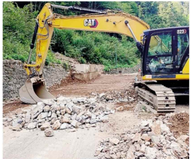
Ancora al lavoro le ruspe in alta Valle Brembana
