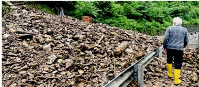
La frana sulla strada a Isola di Fondra
